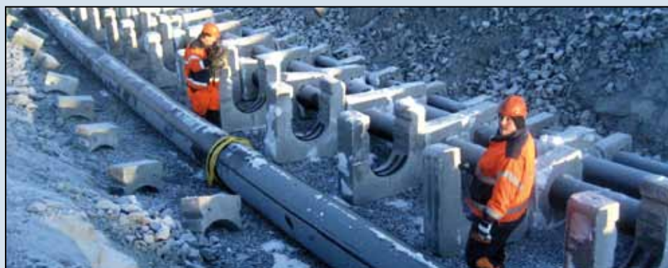
Fyra va-ledningar har grävts ner under kanalen vid Revelsudden.
